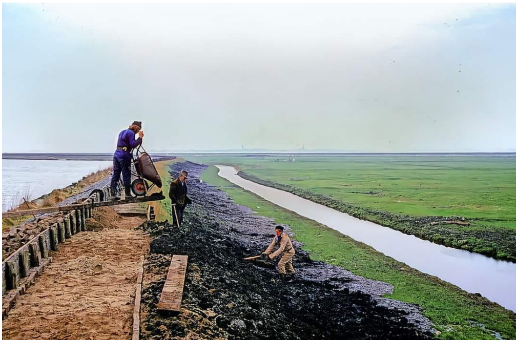
Onderhoud aan de dijk
